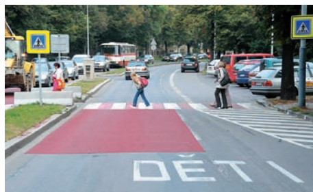
Zřejmě nejlépe chráněný přechod k ZŠ Jeremenkova je doplněn tzv. „rocbindou“, což je zdrsňový červený pás ze strany příjezdu vozidel k přechodu, na kterém vozy lépe zabrzdí.
