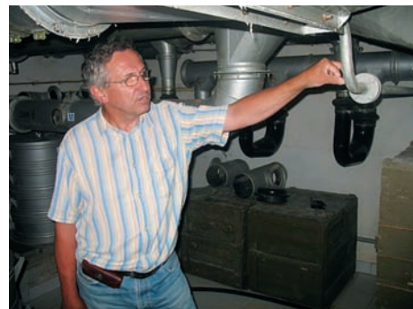
„Celý areál je pravidelně kontrolován. Sterilizátory a tlakové nádoby například každý rok, elektřina a rozvody jednou za pět let,“ říká člen krizového managementu Pavel Florián.
