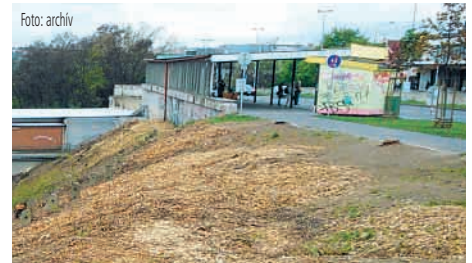
ZDE bude stát nová železniční zastávka Kačerov.
