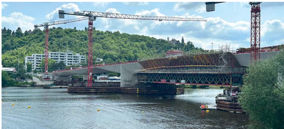
Stavbaři už spojili obě části nového mostu přes Vltavu.
