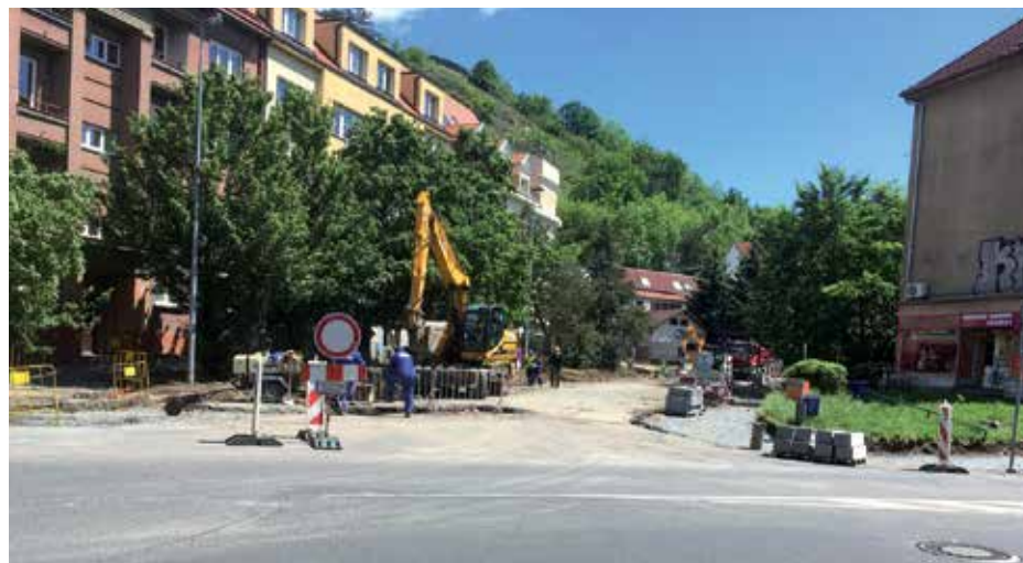
V Branické ulici stavbaři ukončí práce až na podzim.
