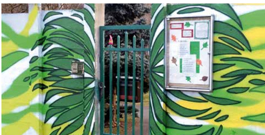
A že se oprava a nový nátěr zdi okolo zahrady u MŠ K Podjezdu opravdu povedl, jasně ukazují i tyto fotografie.
