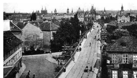
Karlův most z nadhledu v roce 1915.
