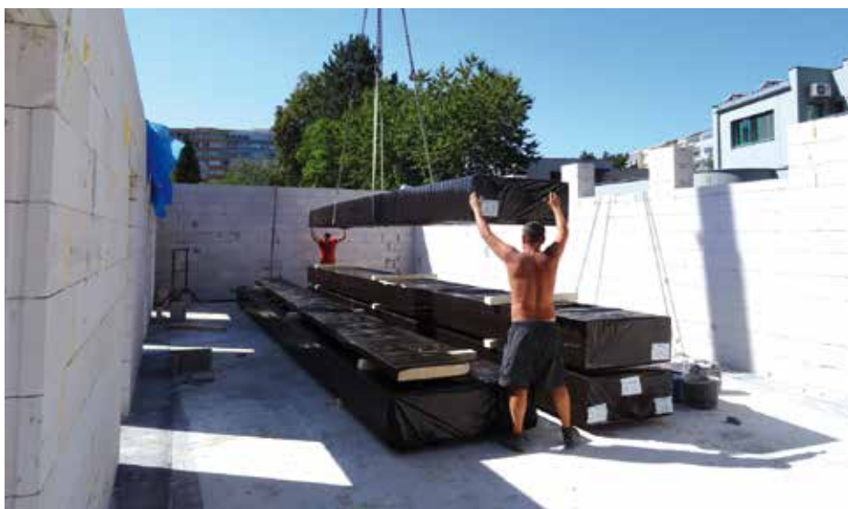
Stavba hlavního objektu koupaliště, ve kterém budou šatny, toalety a sprchy.
