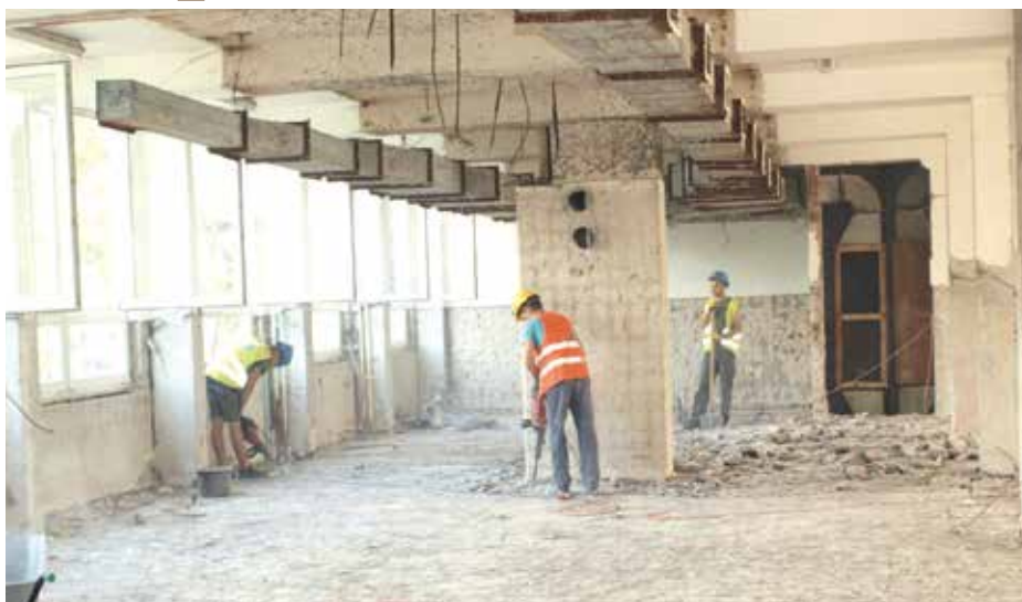
Rekonstrukce kuchyně a jídelny v ZŠ Na Planině.
