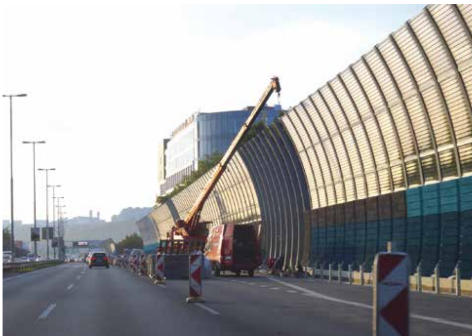
Jedna z nejnovějších protihlukových stěn vyrostla v ulici 5. května.
