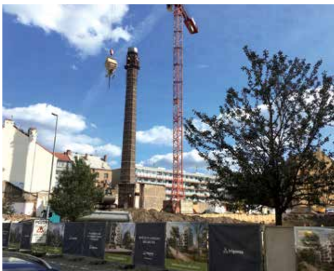
Na staveništi se pilně pracuje.
