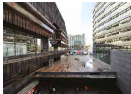
Původní stav terasy před opravou.
