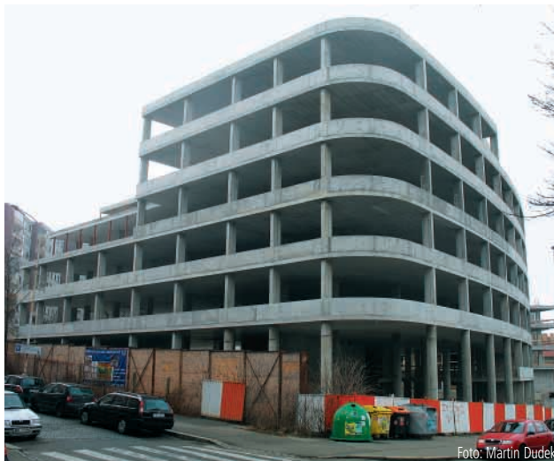
STAVBA v Lomnického ulici je dělníky dočasně opuštěna.
