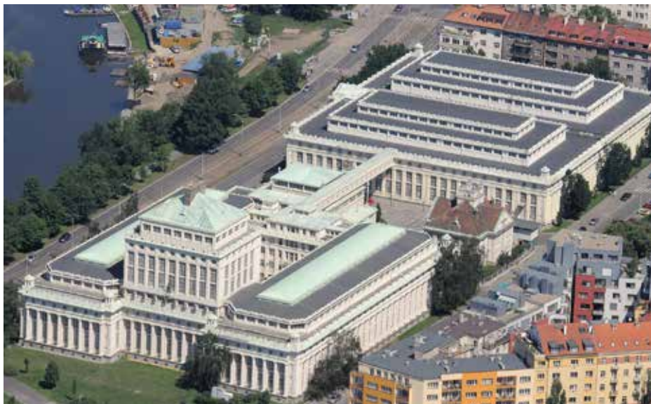
Od začátku nového milénia je Podolská vodárna již jen záložním zdrojem a od poloviny devadesátých let je v ní umístěno Vodárenské muzeum. Foto: archiv
