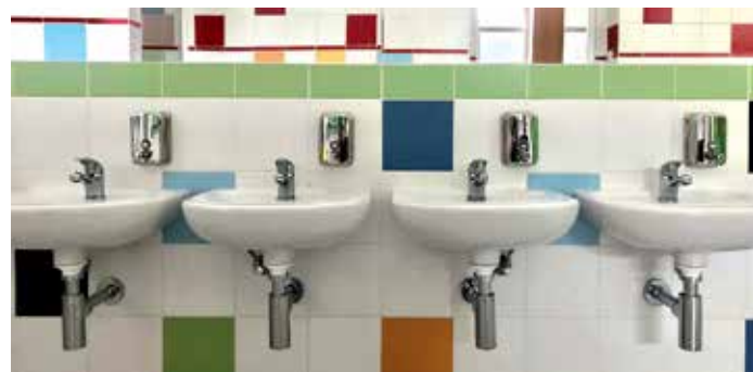
Zrekonstruovaná umývárna v MŠ Alšovy sady.
