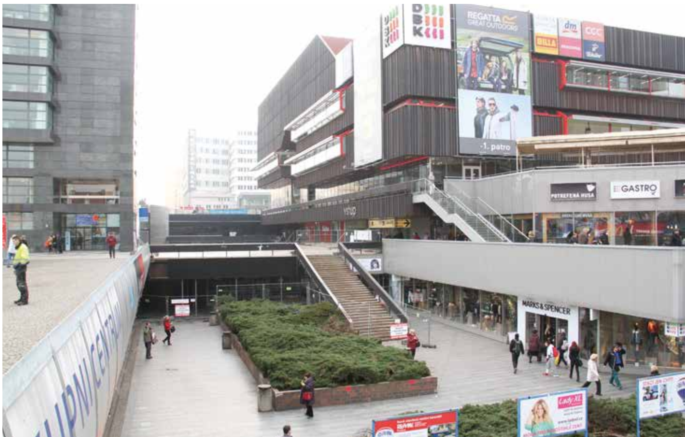
O budoucnosti terasy u obchodního domu DBK je podle posledních zpráv z magistrátu rozhodnuto, půjde k zemi...
