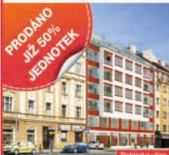
Pohled z ulice
