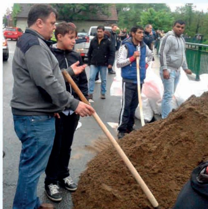
Mgr. Bohumil Zoufalík – starosta MČ Praha 10 pomáhá při výstavbě protipovodňové hráze v Záběhlicích. Červen 2013.
