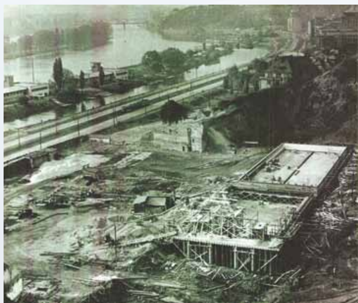
■ ZAHÁJENÍ STAVBY v roce 1960. Foto: archiv JM
