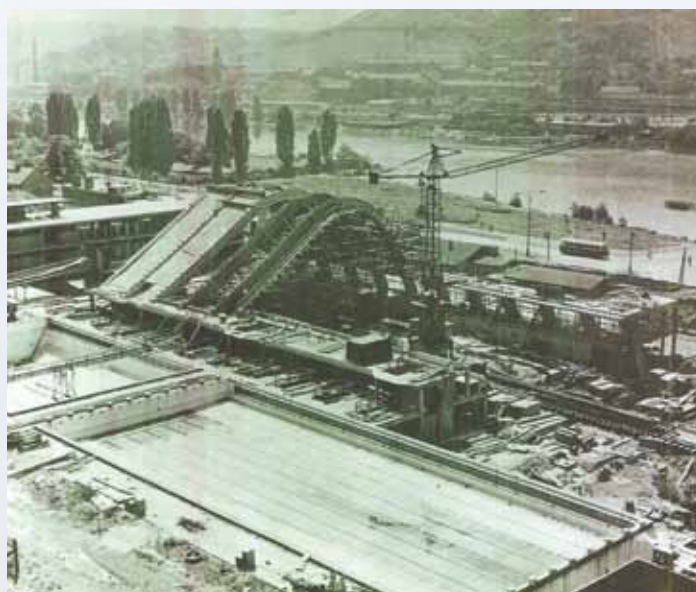
■ KONSTRUKCE TRIBUNY byla postavena na nosných obloucích mostního typu atypického tvaru. Snímek z roku 1963. Foto: archiv JM
