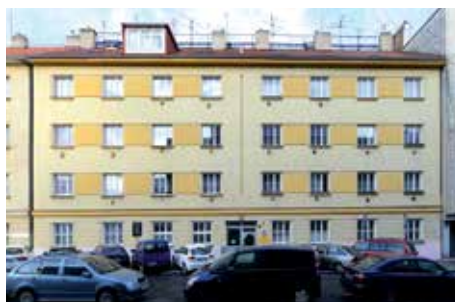
■ NA BITEVNÍ PLÁNI 1063/15A v Nuslích je dům již po rekonstrukci. Foto: MČ Praha 4
