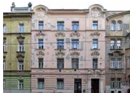
■ NA ZÁMECKÉ 409 v Nuslích se připravuje oprava fasády. Foto: MČ Praha 4
