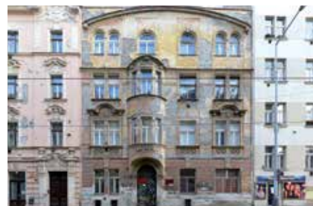
■ NA ZÁMECKÉ 408 dojde k výměně oken, opravě fasády a k sanaci sklepa. Foto: MČ Praha 4
