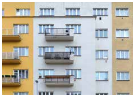
■ V PIKRTOVĚ 1313/5 v Nuslích je dům také po rekonstrukci. Foto: MČ Praha 4
