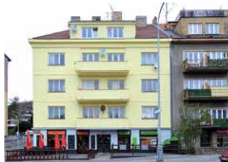
■ DVOREČKÁ 773 v Podolích, zde se připravuje výměna oken. Foto: MČ Praha 4
