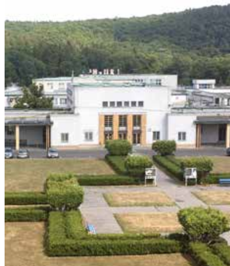
Jeho příjmení nese i krčská nemocnice. Foto: archiv
